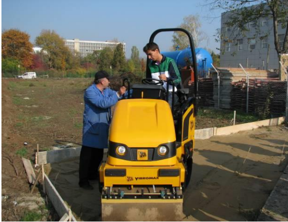
Cilindru vibrocompactor – lucrări practice
