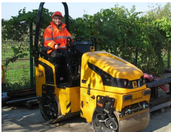
Cilindru vibrocompactor – lucrări practice
